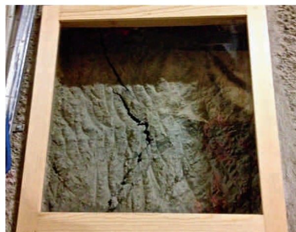
Fig. 5 EDZ (excavation damage zone ou zone perturbée) dans les Argiles à Opalinus du laboratoire Mt Terri (Jura, Suisse) (Photo: M. Buser)
